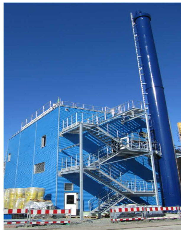
BHKW in Gernsheim: Inbetriebnahme im Juni 2013
